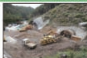
③佐久間第1トンネル(坑口)
