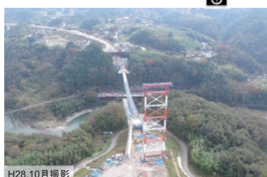
① 天龍峡大橋(仮称)の橋梁上部工事
