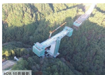
② 龍江IC周辺の橋梁工事
