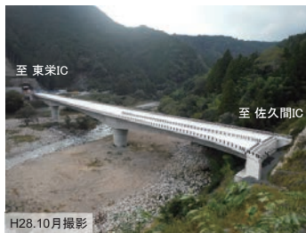
H28.10月撮影 おおちせ がわ 大干瀬川橋(仮称)
