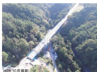
③ 飯田東IC周辺の橋梁上部工事
