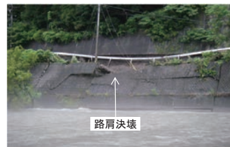
国道418号(長野県天龍村折立付近) (H22.7)
